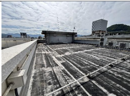
写真1 屋上緑化前の3号棟屋上
