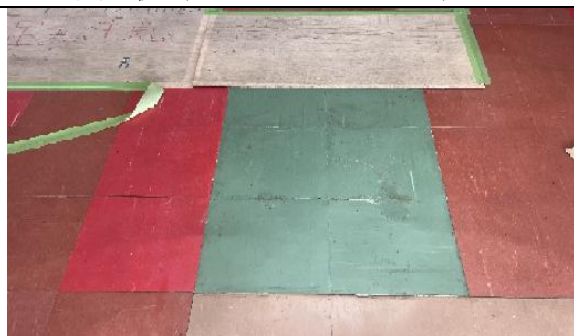
実習棟 P タイル補修
